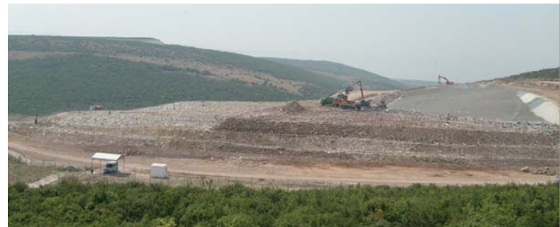
Dilovası Katı Atık Bertaraf Tesisi
