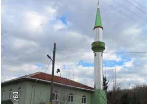
Ferizli Köyü Çelik Minare Yapım İşİ
