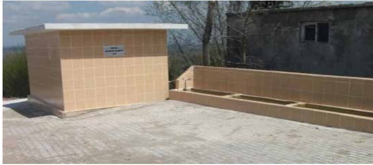
Ortaburun ve Çavuşoğlu Köyleri Su deposu
