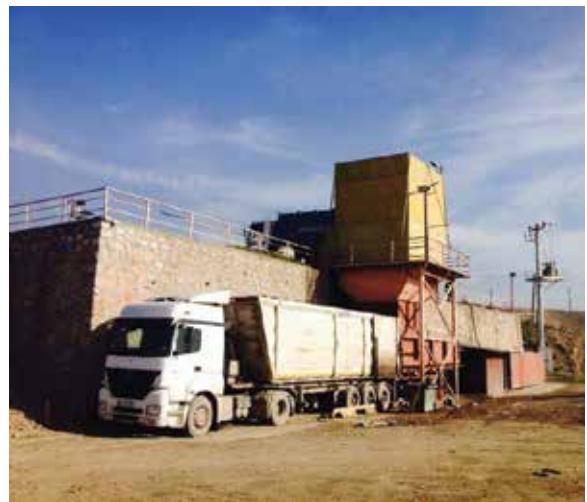
Körfez Katı Atık Aktarma İstasyonu
