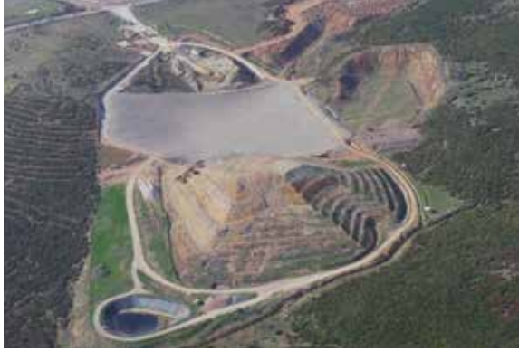
Çiçektepe Mevkii Katı Atık Bertaraf Tesisi
