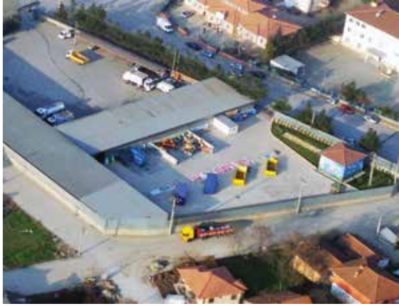
Kartepe İlçesi Atık Getirme Merkezi
