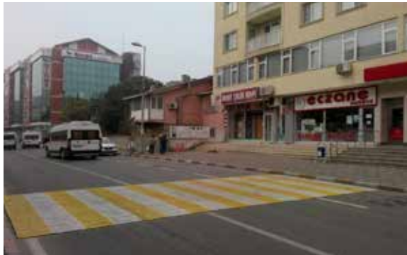
Engelli Uyumlu Kompozit Yaya Geçidi Çalışması
